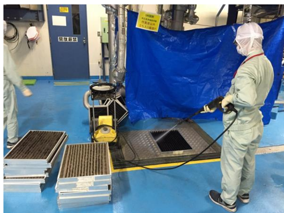
空調フィルターの洗浄作業も大切な作業の一つです。
